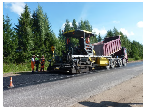
Асфальтирование подъезда с. Верховажье
