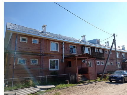
Ремонт крыши многоквартирного дома с. Верховажье
