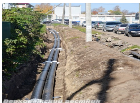
Замена магистральной теплотрассы в с. Верховажье
