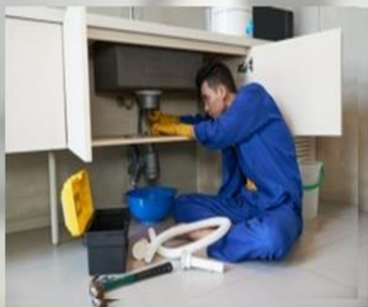
Услуги по производству электромонтажных, сантехнических и сварочных работ
