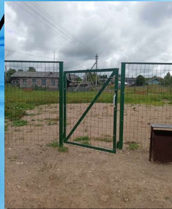
Ограждение спортивной площадки в п. Макарец
