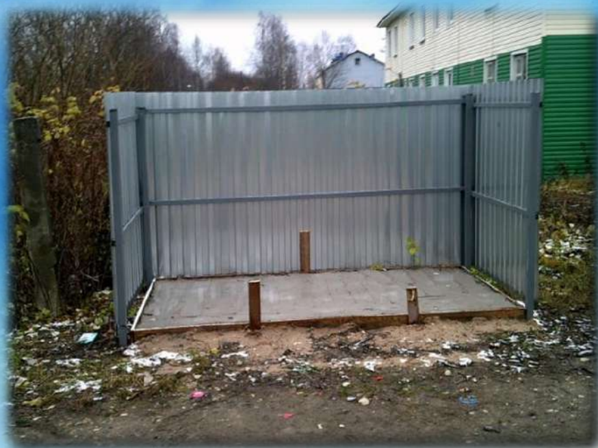
Обустройство контейнерных площадок
