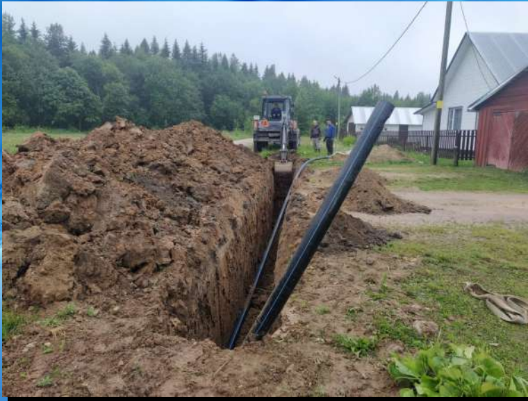
Текущий ремонт водопроводных сетей д. Наумиха
