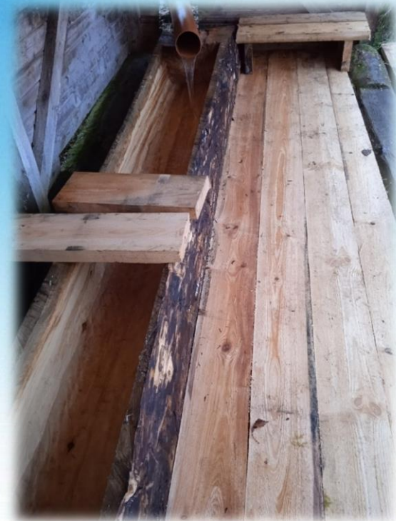
Ремонт природного источника в д.Евсюнинская
