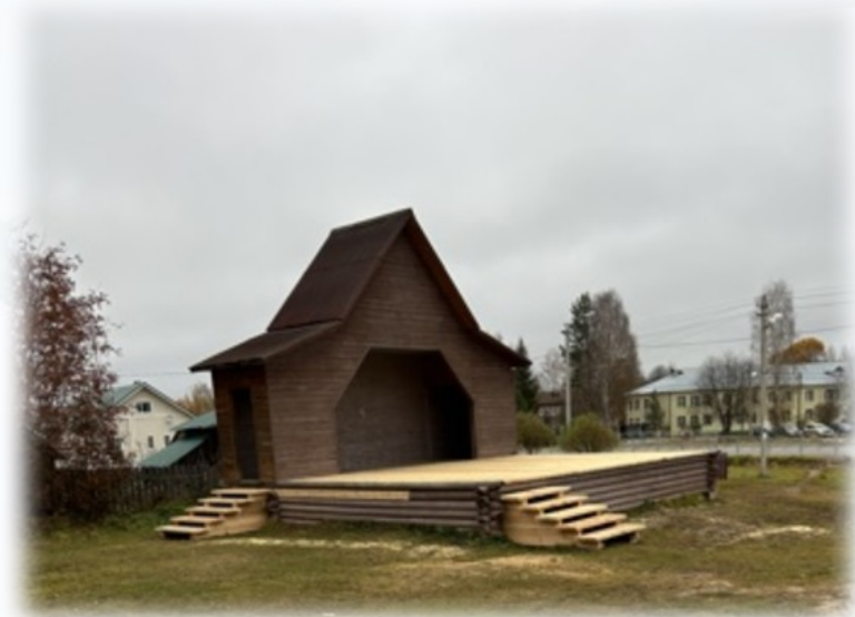
Ремонт уличной сцены в с. Чушевицы
