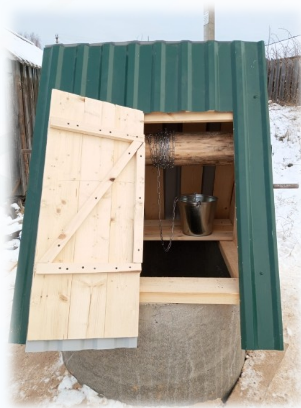
Ремонт қолодца в п. Мақарцево
