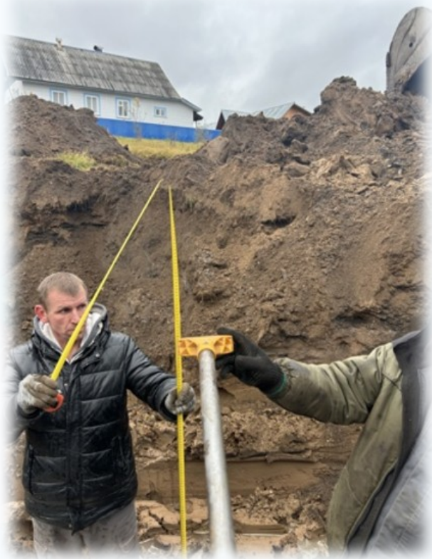
Ремонт водопровода на ул. Молодежная, ул. Заручейная с. Чушевицы
