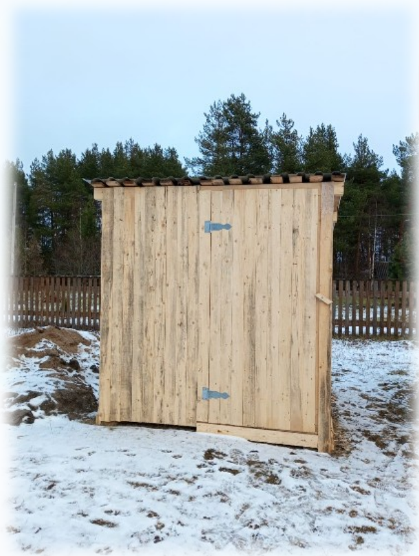
Ремонт қолодца в д. Сметанино
